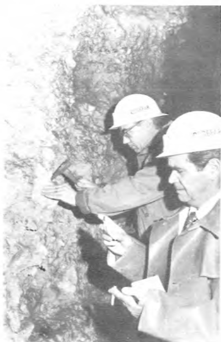
Fig. 3 - Fronte del taglio della galleria nord della prima collina morenica di S. Giacomo a m. 850 in progressiva da est.
