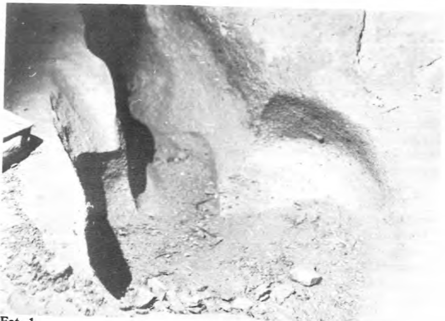
Fot. 1 Esempio di cavità indotta nel tufo nell'agro romano. L'altezza della volta è di circa 7m. Si noti sulla volta la traccia del primitivo cunicolo.
