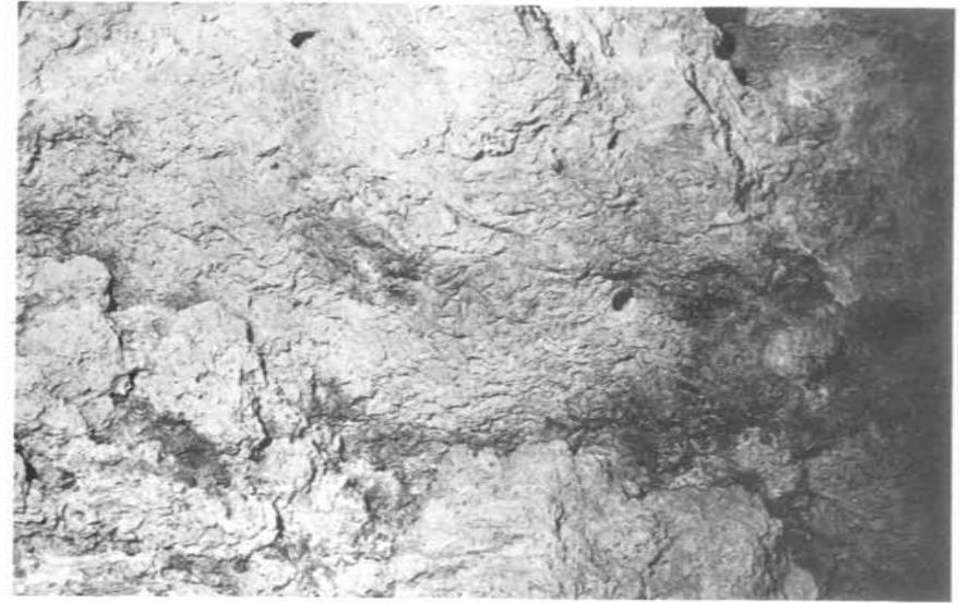
Foto n. 1 ROCCA S. FELICITA: Particolare della parete travertinoso della cavità. Il materiale carbonatico è fortemente vacuolare e fossilifero.
