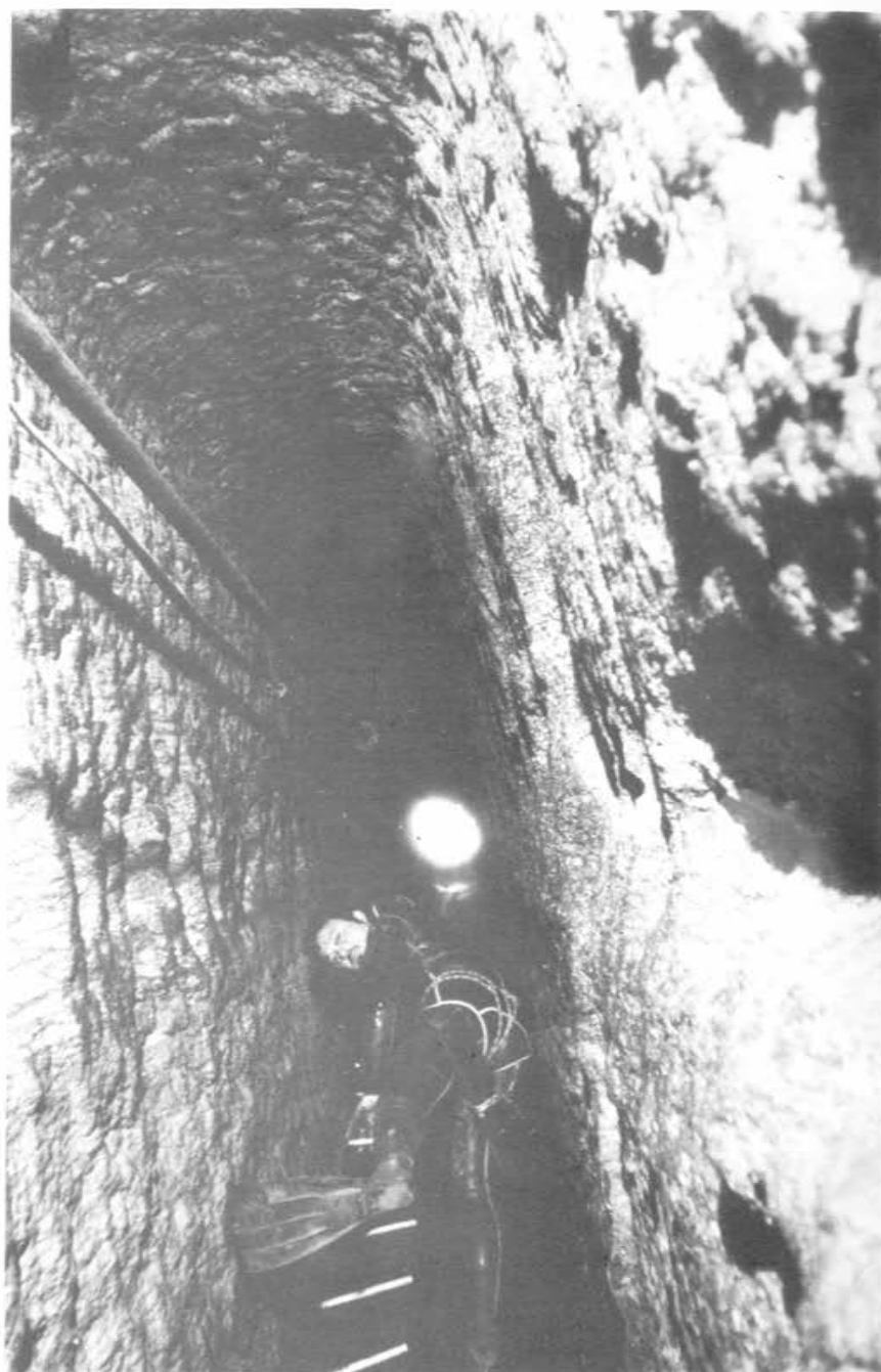
Fig. 4 La discesa a corda doppia del II pozzo consente di inserirsi agevolmente nel cuore del condotto.
