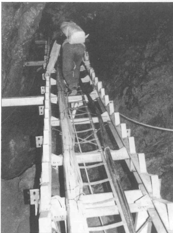
Foto 1 - Trasporto di batterie per la strumentazione di monitoraggio durante i lavori di allestimento turistico nell'Antro del Corchia
